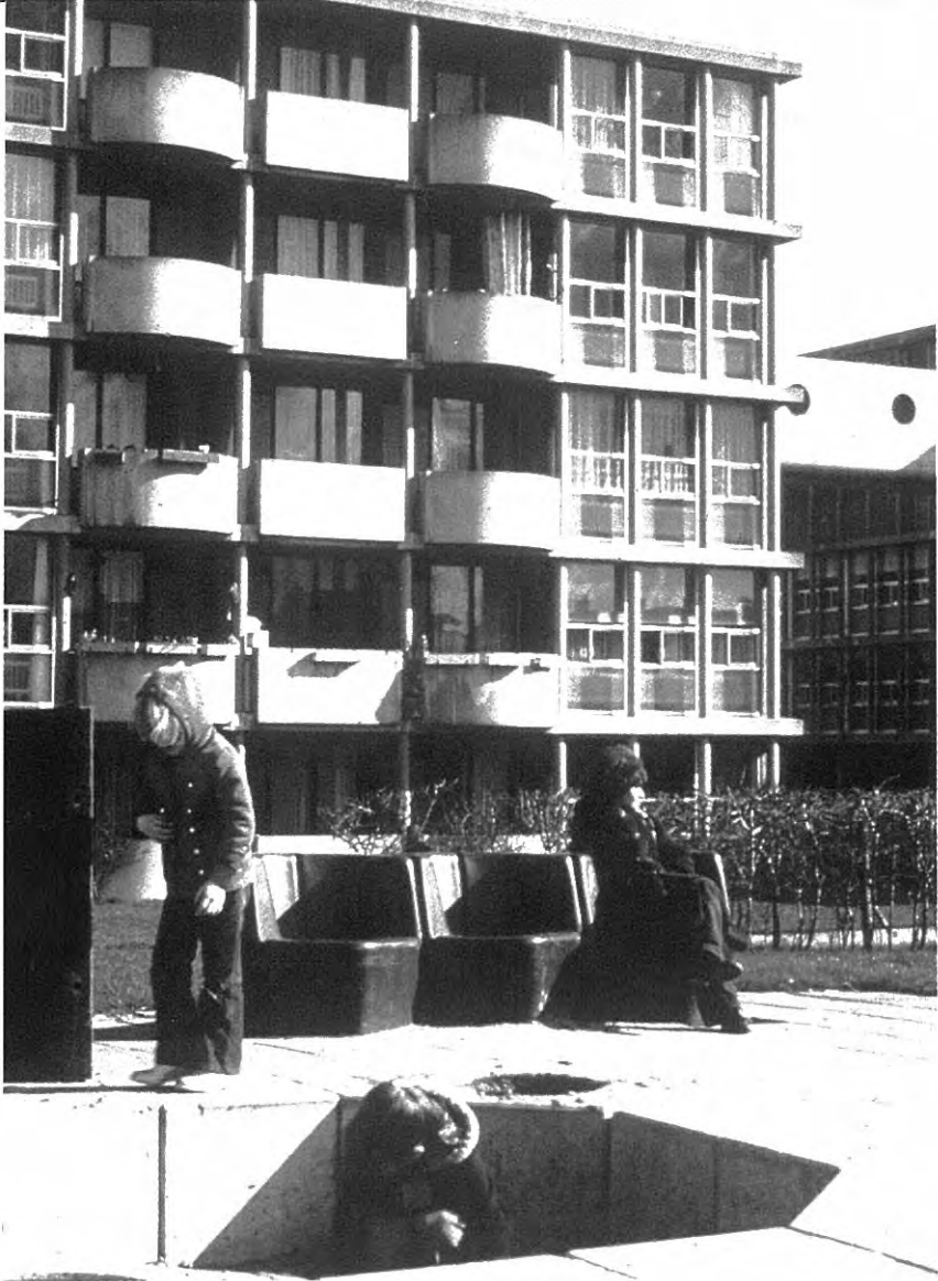
414 Het Breed, Amsterdam Zuidoostgevel met balkons, op de voorgrond een speelplek op een van de pleinen
