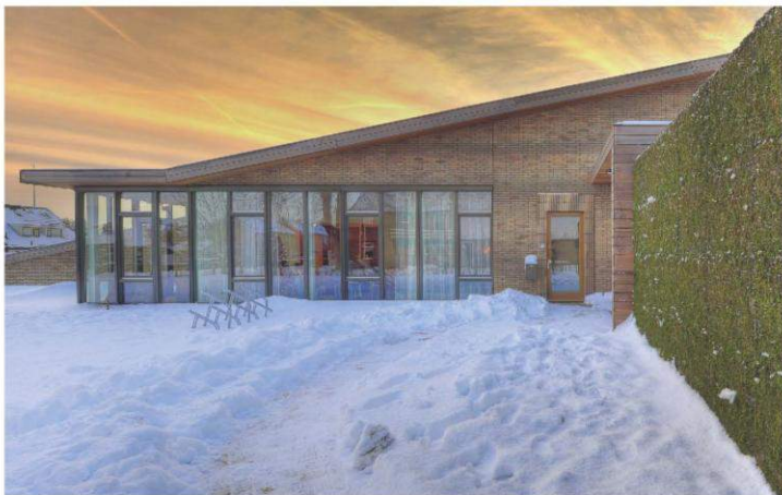
het groene dak begint niet vertikaal
