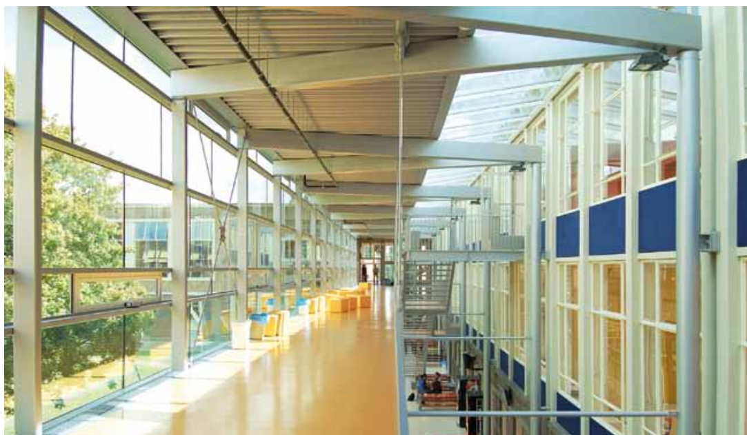
Een nieuwe traverse aan de buitenzijde vormt niet alleen het nieuwe hart van het Stedelijk Gymnasium Arnhem, maar ook een goede isolatie (foto Broekbakema/Dennis Okanovic)
