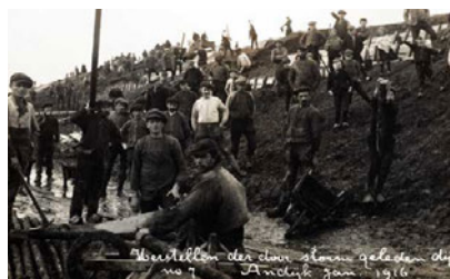
Reparatiewerkzaamheden aan de Westfriese Omringdijk na bijna-dijkdoorbraak in 1916 (bron: P. Jonker, 1916, geheugenvanederland.nl)
