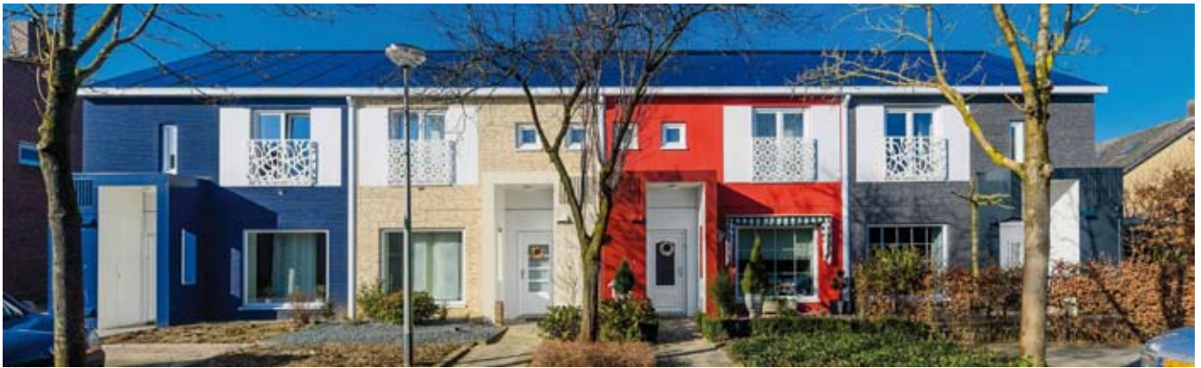
Nul-op-de-meter-huurwoningen in Melick, 2.0 Architecten. ©Stroomversnelling
