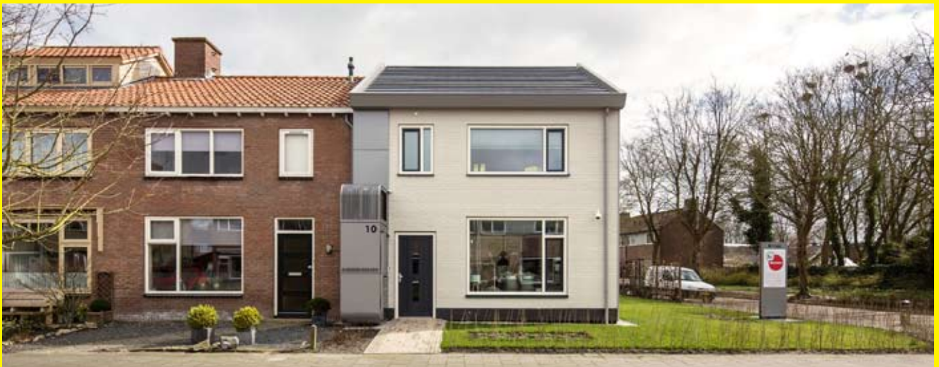
Pilotwoning in Gorredijk. ©Stroomversnelling
