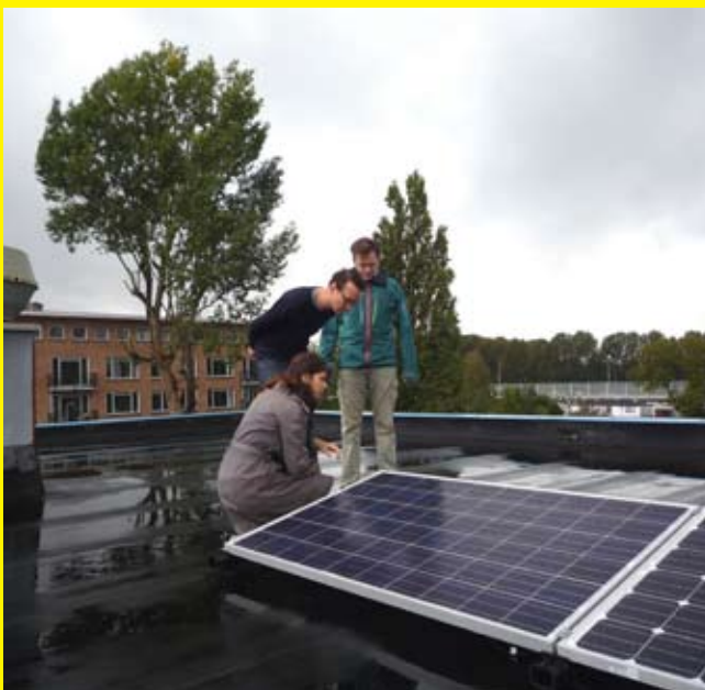
Proefopstelling van zonnepanelen op het dak van een gymzaal in verband met de vergunningaanvraag. ©Blijstroom
