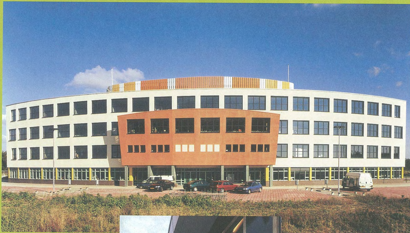
Een gebouw voor de bovenbouw → Candea College, Duiven FOTO Lighthouse Productions, Amersfoort
