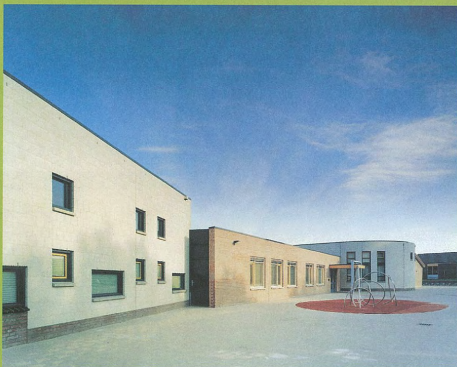
Westgevel → Nutsbasisschool Ganzebloem te Geldrop FOTO Building Images
