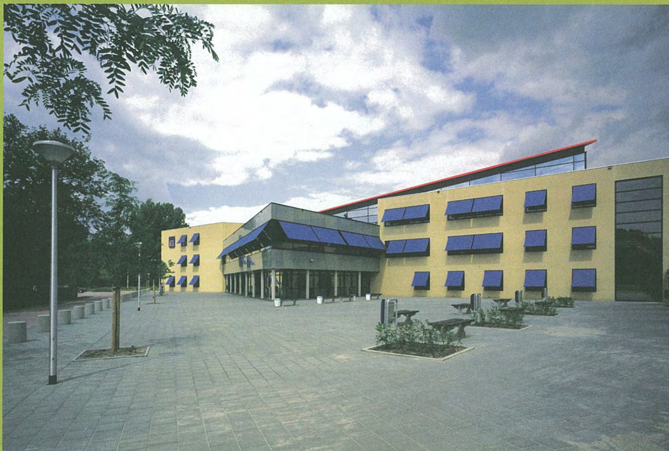
Voorgevel → ELE Eindhoven FOTO Bastiaan IngenHousz
