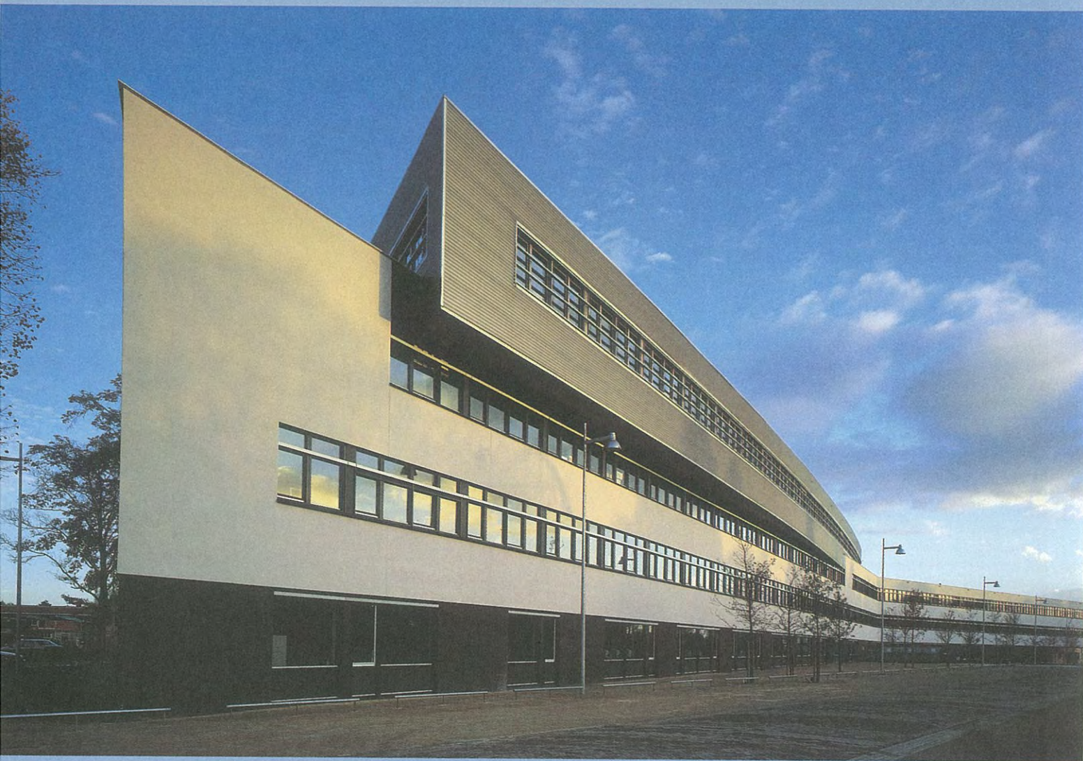
Gevel spoorwegzijde → Dudok College, Hilversum FOTO Michel Claus
