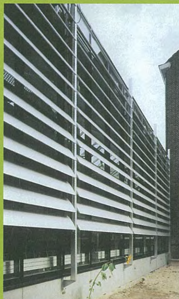
Uitbreiding → Marnix Gymnasium, Rotterdam FOTO P. de Ruig
