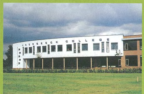
Zuid-westgevel → Heerbeeck College te Best FOTO KdV architecten
