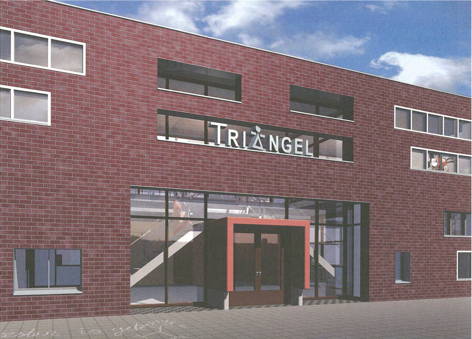
Toegang tot één van de scholen in het project → Welzijnsvoorzieningen Delfgauw (oplevering eind 2000) VISUALISATIE XX architecten
