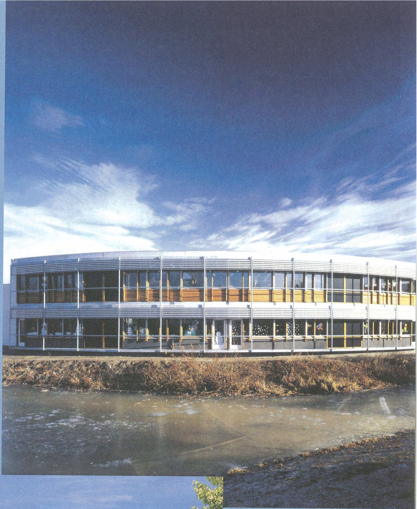
Nieuwbouw ➔ Openbare Basisschool Rubenshof, Oosterhout FOTO Arjen Schmitz, Maastricht
