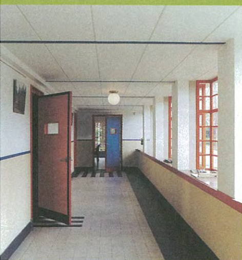
Renovatie (Dudokschool) → Kleuterschool Nienke van Hichtum te Hilversum FOTO Ruud van Roon, Hoevelaken
