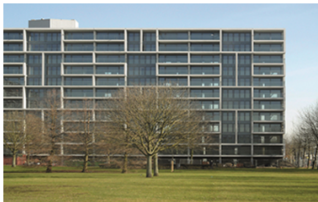
De Margrietflat heeft een nieuwe, luxere uitstraling gekregen. De architecten wonnen er de Rotterdamse Architectuurprijs mee.
