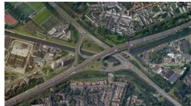
Luchtfoto van de huidige situatie bij het knooppunt Gooiseweg (S112): de infrastructuur domineert de Weespertrekvaart / Aerial photo of the current situation at the Gooiseweg (S112) node: the infrastructure dominates the Weespertrekvaart
