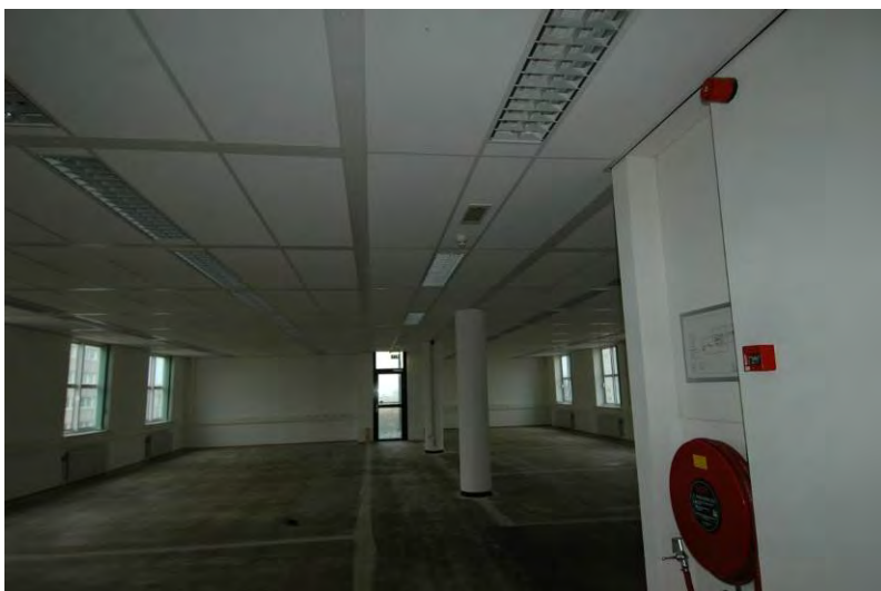
Bestaande situatie na sloop
