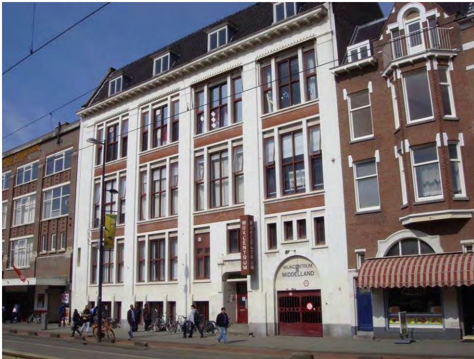
Voorgevel bestaand gebouw
