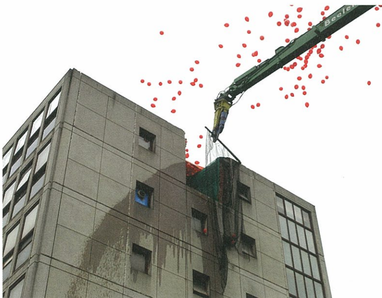
Sloop van het Swammerdam Instituut in Amsterdam, een door Amsterdammers weinig geliefd gebouw uit de jaren zestig van de vorige eeuw en niet meer te hergebruiken voor andere functies.
