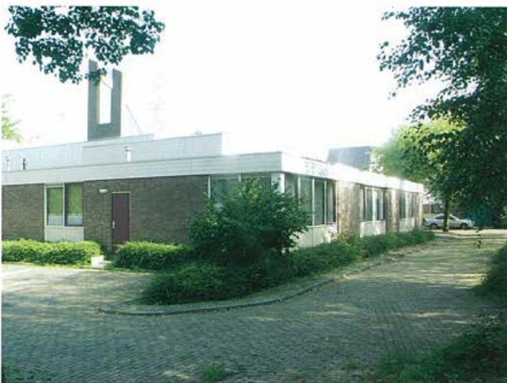
achterzijde bestaand kerkgebouw
