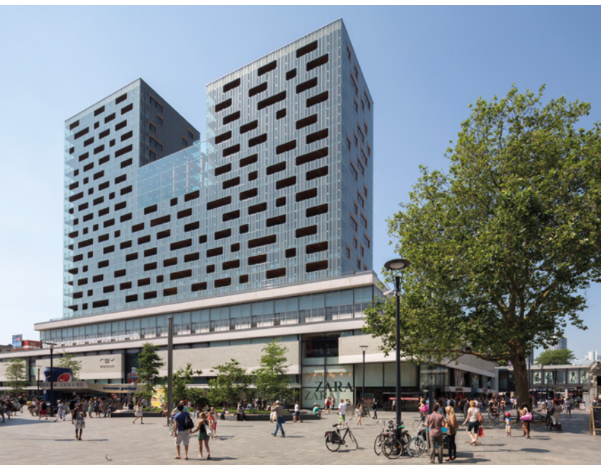
Het getransformeerde pand anno nu. Foto: Ossip van Duivenbode
