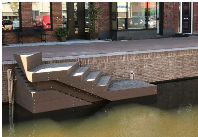
Beeld: De Bioloop van nextcity.nl zorgt ervoor dat ook kleine dieren die van zwemmen houden in en uit de grachten in Delft kunnen klimmen. Bron: Diny Tubbing
