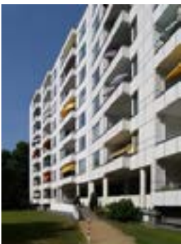
Afb. 2: Gebouw met trapwijs geplaatste balkons (Seier, z.d.).
