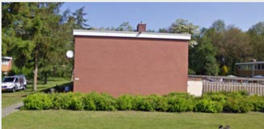
Afb. 5: Zij aanzicht van laagbouw (Google Maps, z.d.).
