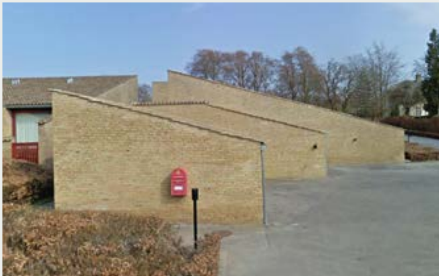
Afb. 3: Zij aanzicht van laagbouw (Google Maps, z.d.).
