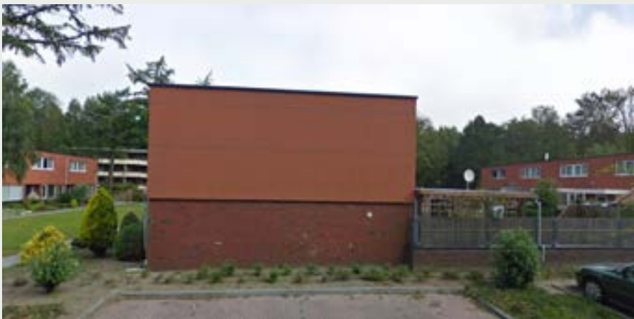
Afb. 8: Zij aanzicht van laagbouw (Google Maps, z.d.).
