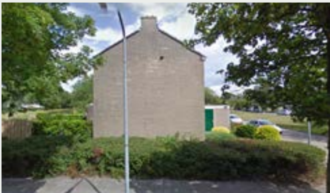
Afb. 4: zij aanzicht van laagbouw (Google Maps, z.d.).
