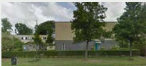
Afb. 4: Zij aanzicht van laagbouw (Google Maps, z.d.).
