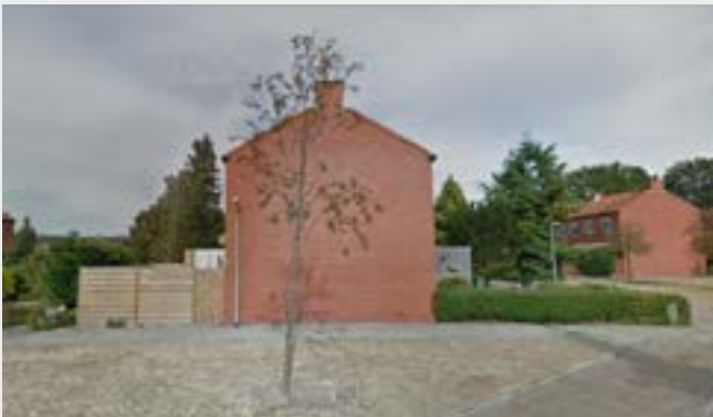
Afb. 2: zij aanzicht van laagbouw (Google Maps, z.d.).
