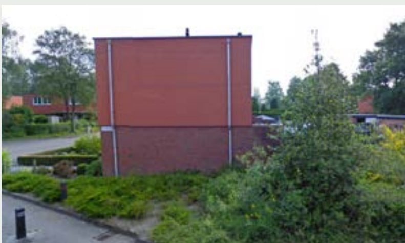
Afb. 7: Zij aanzicht van laagbouw (Google Maps, z.d.).
