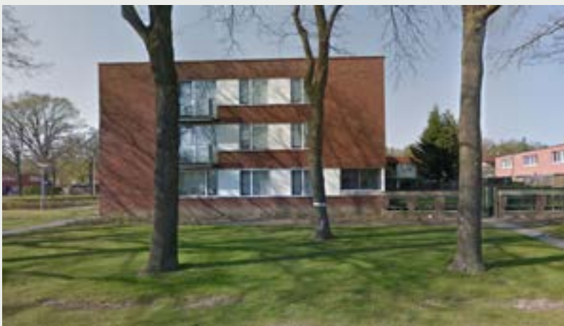
Afb. 9 : Zij aanzicht van laagbouw (Google Maps, z.d.).
