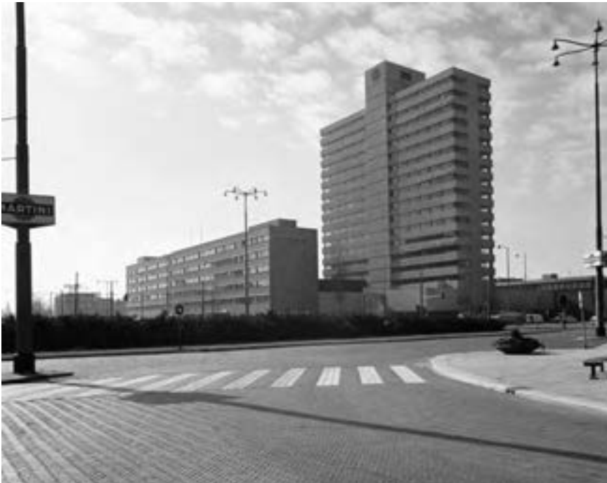
Gezicht op het Bouwcentrum aan het Weena, 1972. Bron: Stadsarchief Rotterdam
