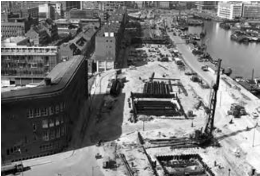
GGD-gebouw met bouwput metrotunnel in 1963. Foto: Ary Groeneveld. Bron: Stadsarchief Rotterdam
