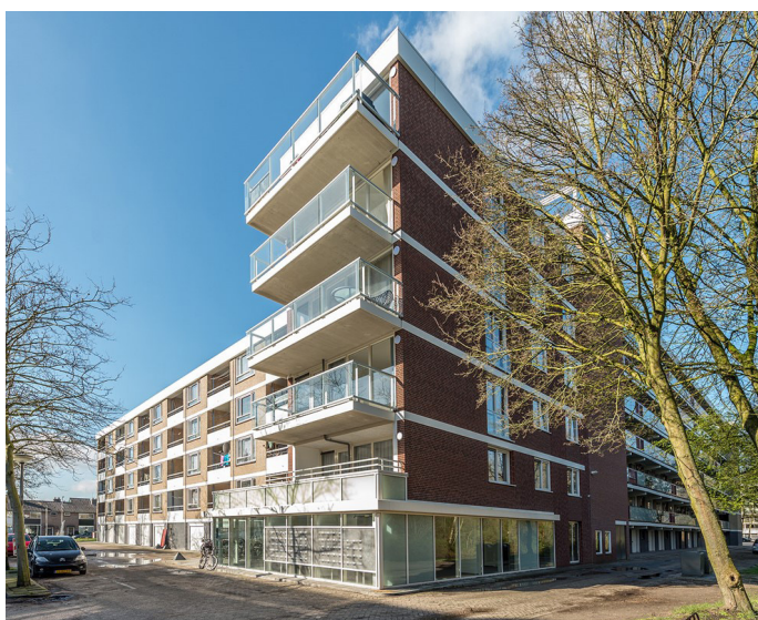
Transformatie van gesloten hoeken en blinde kopgevels, Amersfoort
