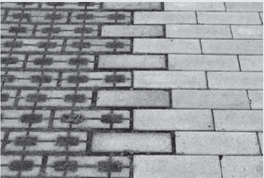
Deze poreuze bestrating van Bureau Hosper laat ruimte voor het ontstaan van leven.
