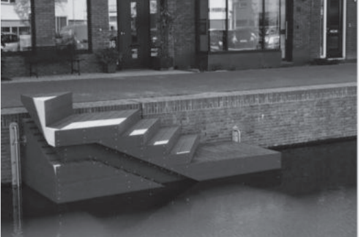
De Bioloop van nextcity.nl zorgt ervoor dat ook kleine dieren die van zwemmen houden in en uit de grachten in Delft kunnen klimmen.
