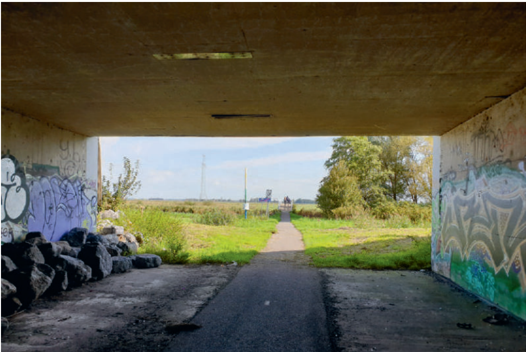
Onderdoorgang van de A10 naar Waterland
