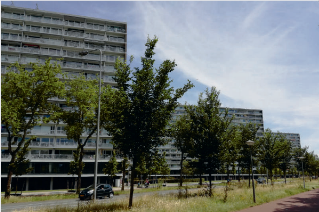
Flats aan de Noordoever met uitzicht op de Sloterplas
