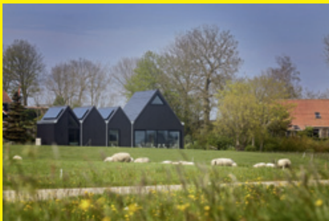
> Bezoekerscentrum Hegebeintum Architect: TWA Architecten Opdrachtgever: Stichting TERP Hegebeintum Bouwperiode: 2020-08-17 tot 2021-03-01 Fotograaf: Gerard van Beek
