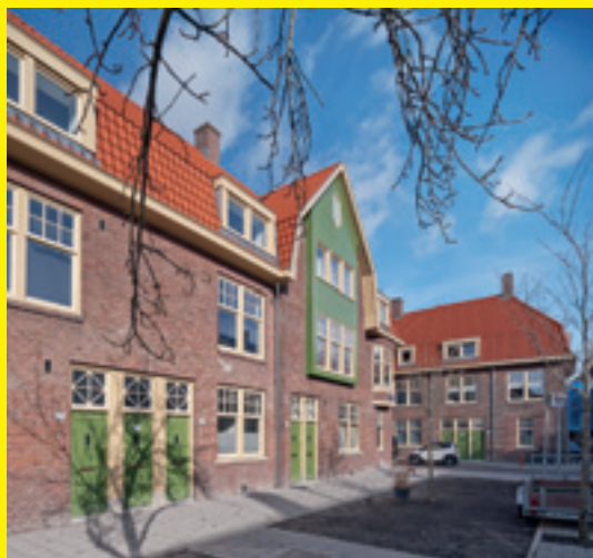
> Blok 6 en 7 Gentiaanbuurt, Amsterdam Architect: Ibelings van Tilburg architecten Opdrachtgever: Woonstichting Ymere Bouwperiode: 2020-09-20 tot 2021-10-08 Fotograaf: Petra Appelhof
