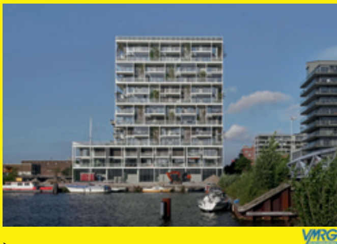
> Stories, Amsterdam Architect: Olaf Gipsier Architects Opdrachtgever: Bouwgroep CPO Samenwerkers BSH20A Bouwperiode: 2018-11-16 tot 2021-04-14 Fotograaf: Max Hart Nibbrig
