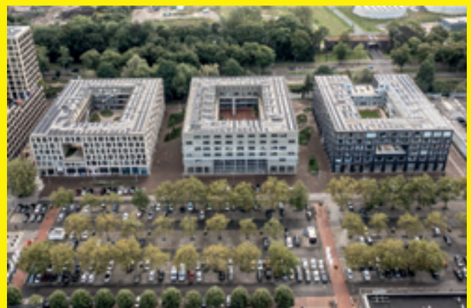
> DeBuurt, Utrecht Architect: Paul de Ruiter Architects Opdrachtgever: AM Real Estate Development Bouwperiode: 2019-04-01 tot 2021-06-01 Fotograaf: Ossip van Duivenbode
