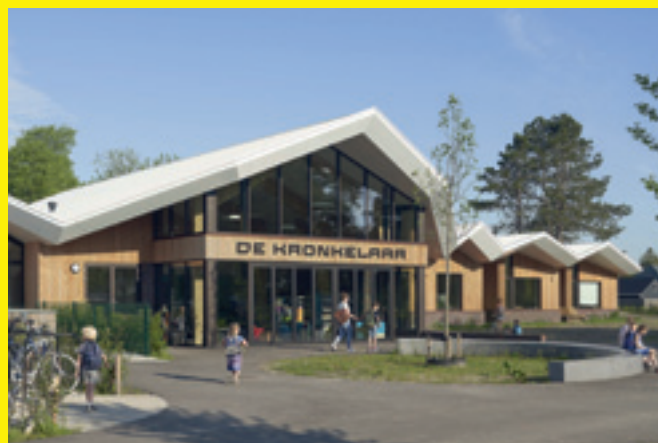
> Kindcentrum De Kronkelaar, Wagenborgen Architect: Onix NL Opdrachtgever: Gemeente Eemsdelta Bouwperiode: 2019-09-02 tot 2020-12-18 Fotograaf: Gerald van Beek
