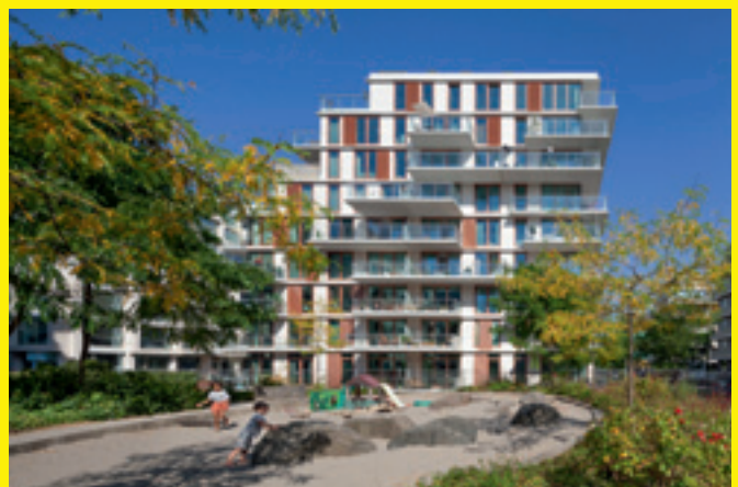
> The Row, Amsterdam Architect: DP6 architectuurstudio Opdrachtgever: Amvest Bouwperiode: 2018-09-17 tot 2021-04-05 Fotograaf: Scagliola Brakkee
