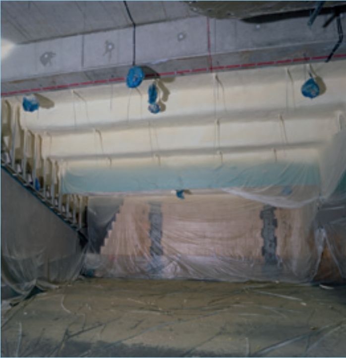
Onderzijde tribune voorzien van naadloze isolatielaag afgewerkt met vlamvertragende coating
