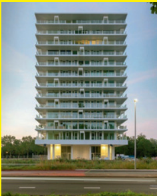
> De Voortuinen, Amsterdam Architect: Elephant Opdrachtgever: Westerpark West Bouwperiode: 2019-03-04 tot 2021-09-20 Fotograaf: Marcel van der Burg
