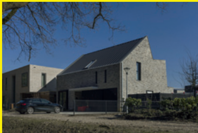
> Elburglaan, Eindhoven Architect: Architecten studio-pls Opdrachtgever: Van den Reek Bouwperiode: 2020-02-01 tot 2021-07-01 Fotograaf: Maurits van Hout
