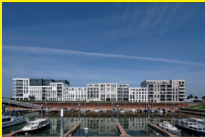
> Noorderhaven Kade Noord Architect: Zecc Architecten en KCAP Opdrachtgever: Heijmans Vastgoed Bouwperiode: 2019-04-02 tot 2021-05-12 Fotograaf: Ossip van Duivenbode
