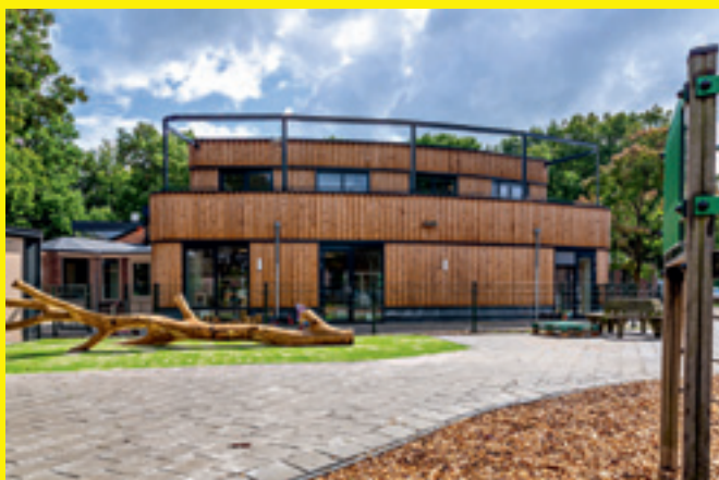
> 't Ronde Montessori kindcentrum, Leusden Architect: studioWA! Opdrachtgever: Vereniging voor Montessori Onderwijs Leusden Bouwperiode: 2020-08-01 tot 2021-08-20 Fotograaf: Mariëlle Debrinchy
