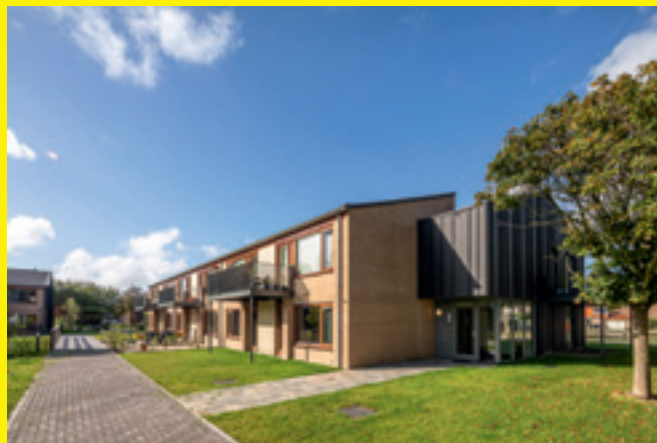
> Winkelmadepark, Winkel Architect: AB101 i.s.m. Ted Schulten architecten Opdrachtgever: Wooncompagnie Bouwperiode: 2015-02-02 tot 2021-07-30 Fotograaf: Jaap Lotstra
