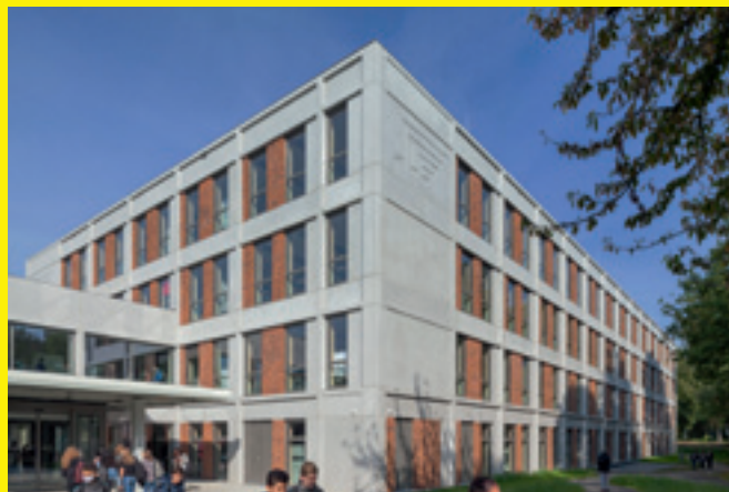
> SCE Henegouwenlaan, Eindhoven Architect: DP6 architectuurstudio Opdrachtgever: Stichting Internationaal en Lokaal Funderend Onderwijs Eindhoven Bouwperiode: 2020-01-06 tot 2021-06-28 Fotograaf: Michel Kievits
