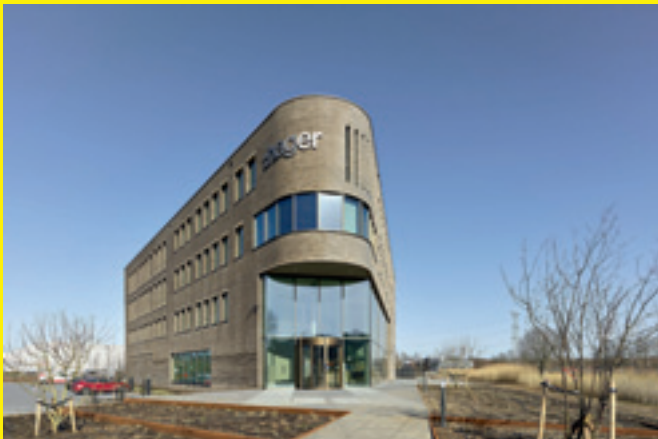
> Experience center Hager, 's-Hertogenbosch Architect: Architectenbureau De Twee Snoeken Opdrachtgever: Hager Electro B.V. Bouwperiode: 2021-01-04 tot 2021-12-08 Fotograaf: Joep Jacobs
