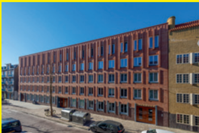
> Startblok Wormerveerstraat, Amsterdam Architect: Kenk architecten Opdrachtgever: Woonstichting Lieven De KEY Bouwperiode: 2020-10-14 tot 2021-12-03 Fotograaf: Roos Aldershoff
