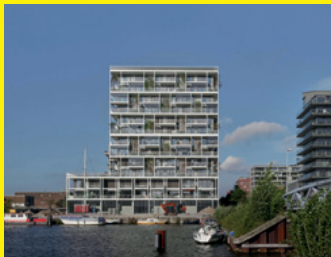
> Stories, Amsterdam Architect Olaf Gipser Opdrachtgever Bouwgroep CPO Samenwerkers BSH20Ar
