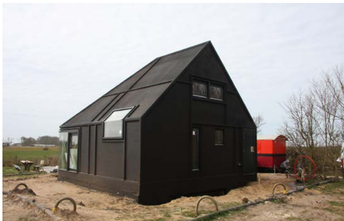
Door het spuitrubber is het huis wind en waterdicht
