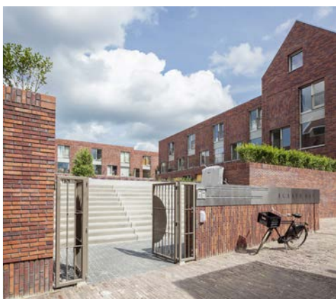
Gemeenschappelijk hofje boven de parkeergarage
