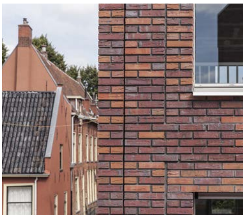
Metselwerk sluit aan bij de historische omgeving
