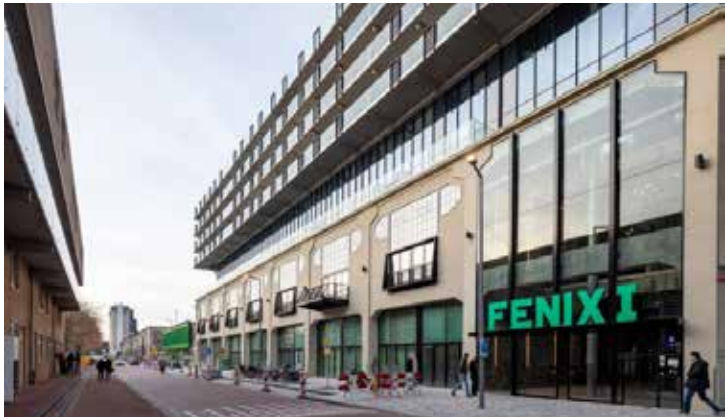
Geleding aan de Veerlaan
