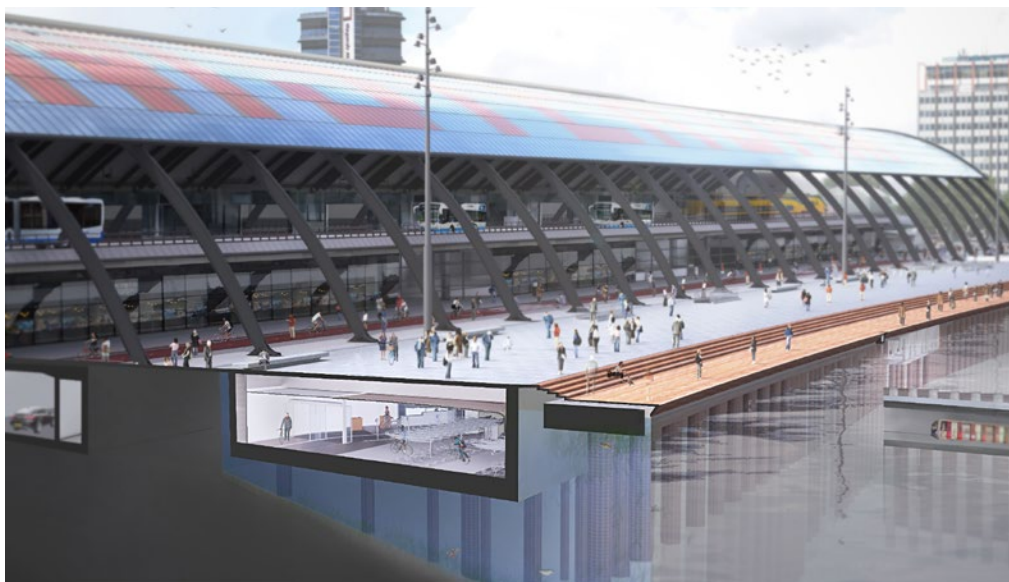
De inpassing van IJboulevard tussen de overkapping van busstation Amsterdam Centraal, de Michiel de Ruijter auto-tunnel (links), en de aanvaarbescherming en de tunnel voor de Noord/Zuidlijn (rechts).
