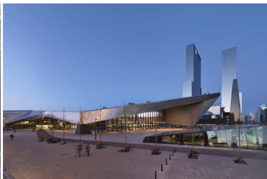
Het puntige dak van de hal, geheel bekleed met RVS, maakt het gebouw iconisch en wijst naar het hart van de stad Rotterdam.
