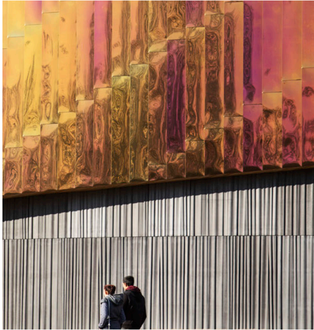
Betonnen plint met roestvrijstalen lint erboven
