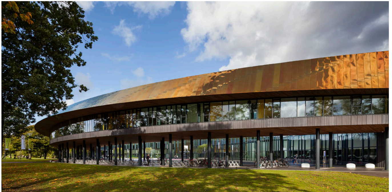
draaien van het roestvrijstalen lint om beglazing te onthullen
