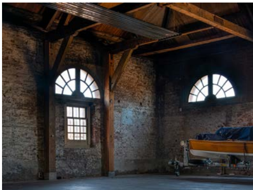
Gebouw 66, voor aanvang van de renovatie
