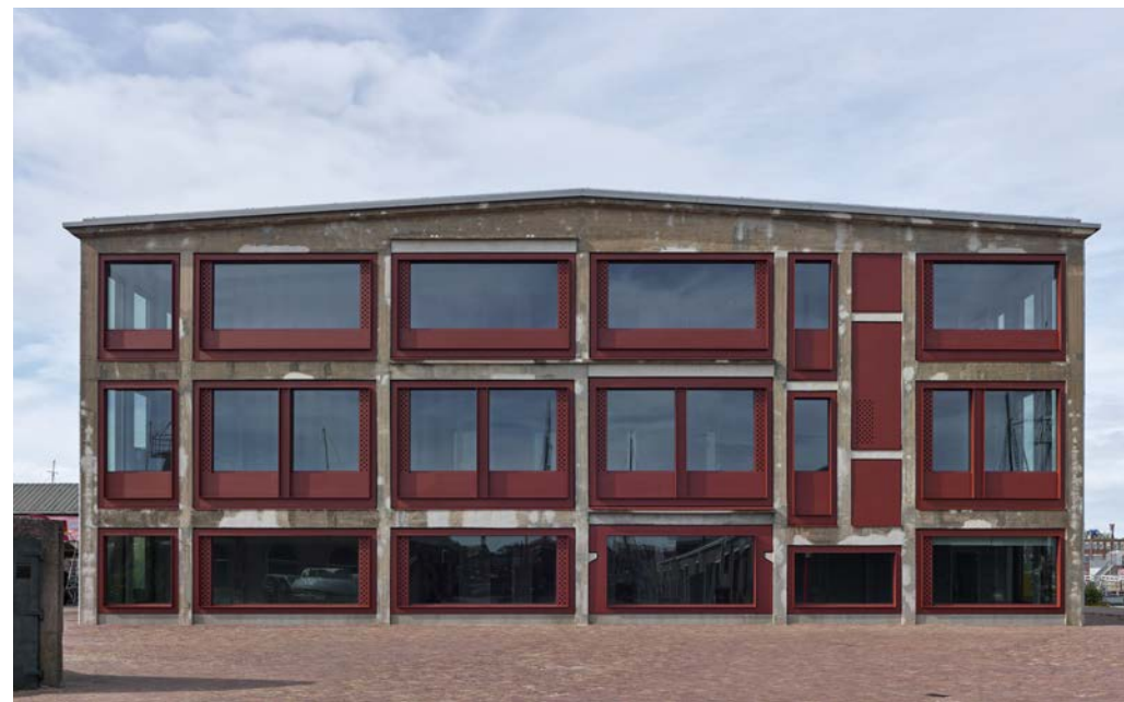
De nieuwe zuidgevel gebouw 72
