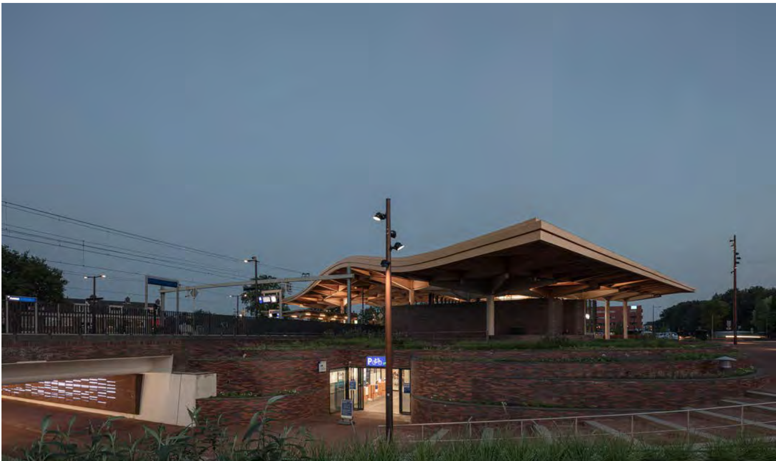
De ondergrondse fietstunnel en entree naar de ondergrondse fietsenstalling
