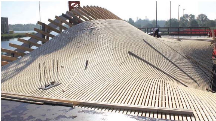
Alvorens de bekistingsplaat aan te brengen, is het golvend betonnen schaaldak gevormd door het aanbrengen van stroken met latjes.
