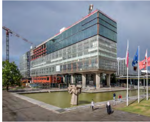
Bouwfase: oude en nieuwe gevel
