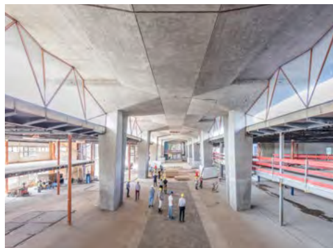
Renovatie-bouwfase, sloop loopbrug
