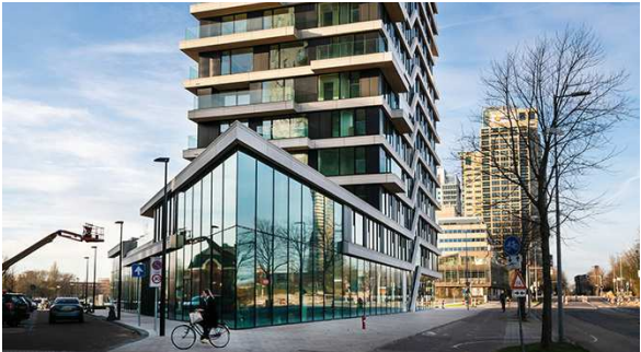
Later in 2023: Health Club in de plint. Bovenop een daktuin.
