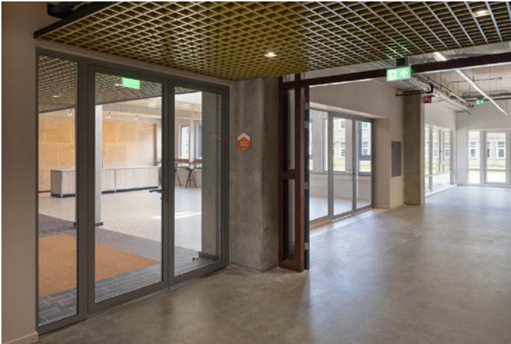
Nieuwe verbinding tussen het kantoor met de rest van het complex door plaatsen van herwonnen brandwerende puien.
