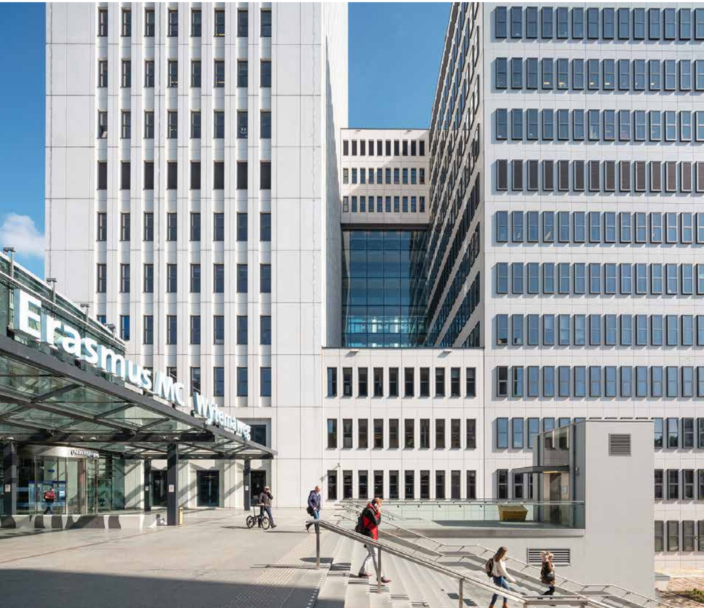
Gearieerd gevelbeeld door diepe neggen, erkers en verschillend afgewerkte betonnen geveldelen
