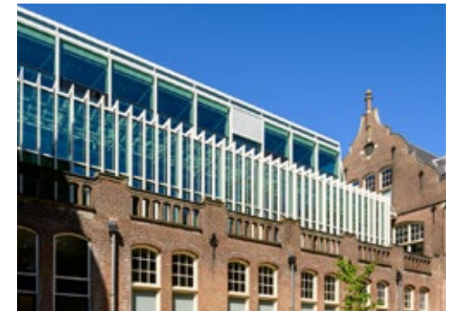
De nieuwe serre op het dak van de zuidvleugel
