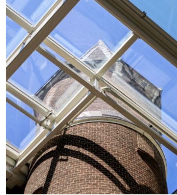
Aansluiting nieuwe overkapping op bestaand torentje
