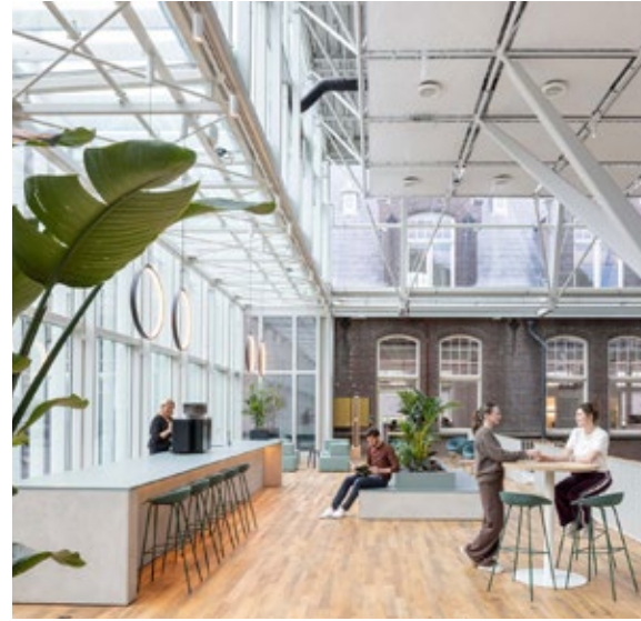
Aansluiting nieuwe serre op de zuidgevel
