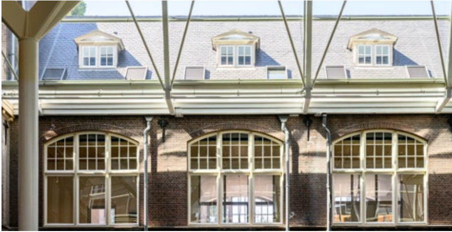
Aansluiting nieuwe overkapping op bestaand gebouw
