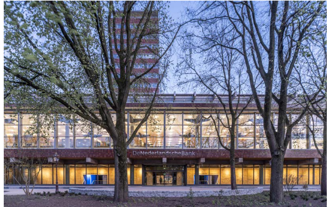
De hoofdingang is verplaatst naar een zijde zonder directe burens en is dwars door de voormalige goudkluis heen gezaagd
