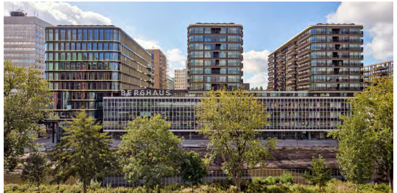
Noordgevel: Berghaus gezien vanaf de Schipluidenlaan
