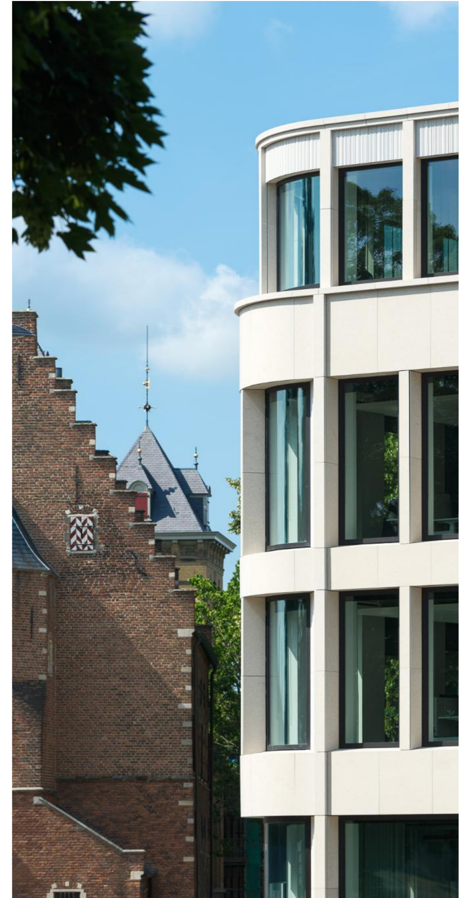
Detail van de vriendelijke, afgeronde hoek als verbinding tussen de historische wal met het natuurgebied naar de Bossche historische binnenstad
