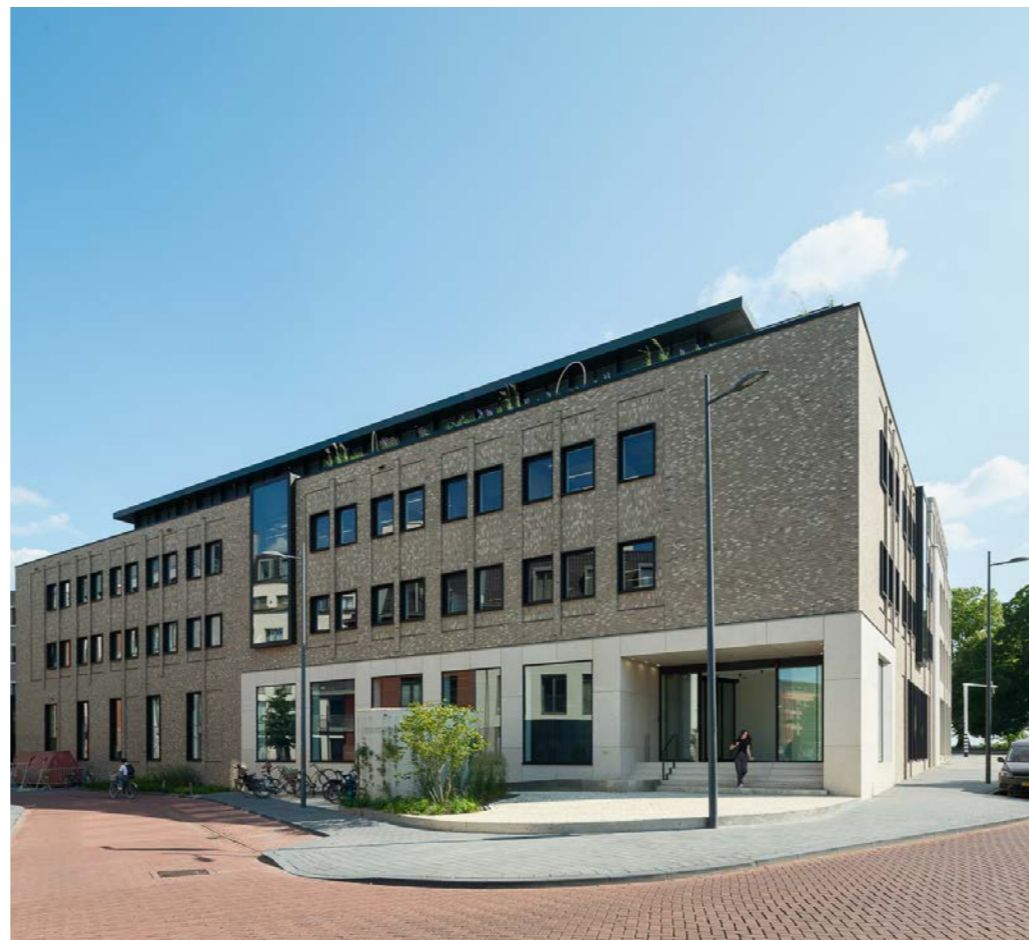
Getransformeerde gevel aan de stadszijde: in metselwerk met nieuwe, strategische openingen - waaronder een groot panoramavenster en een dynamische plint met entree
