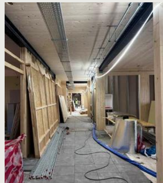
hergebruikte betonnen tegels tbv geluidswering
