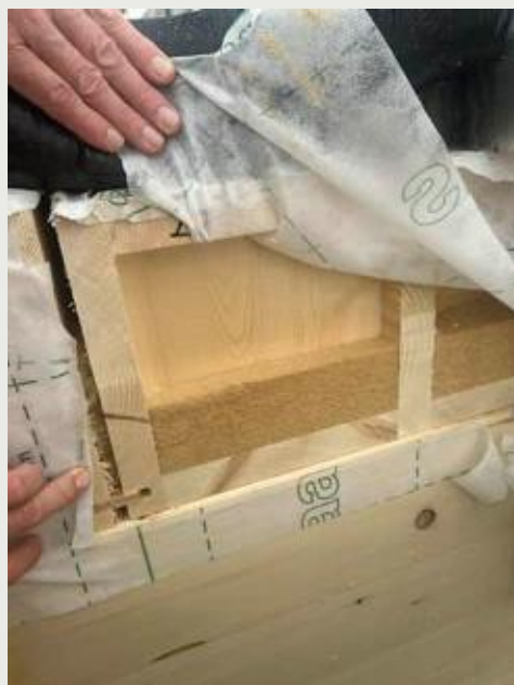
houten kanaalplaat vloeren
