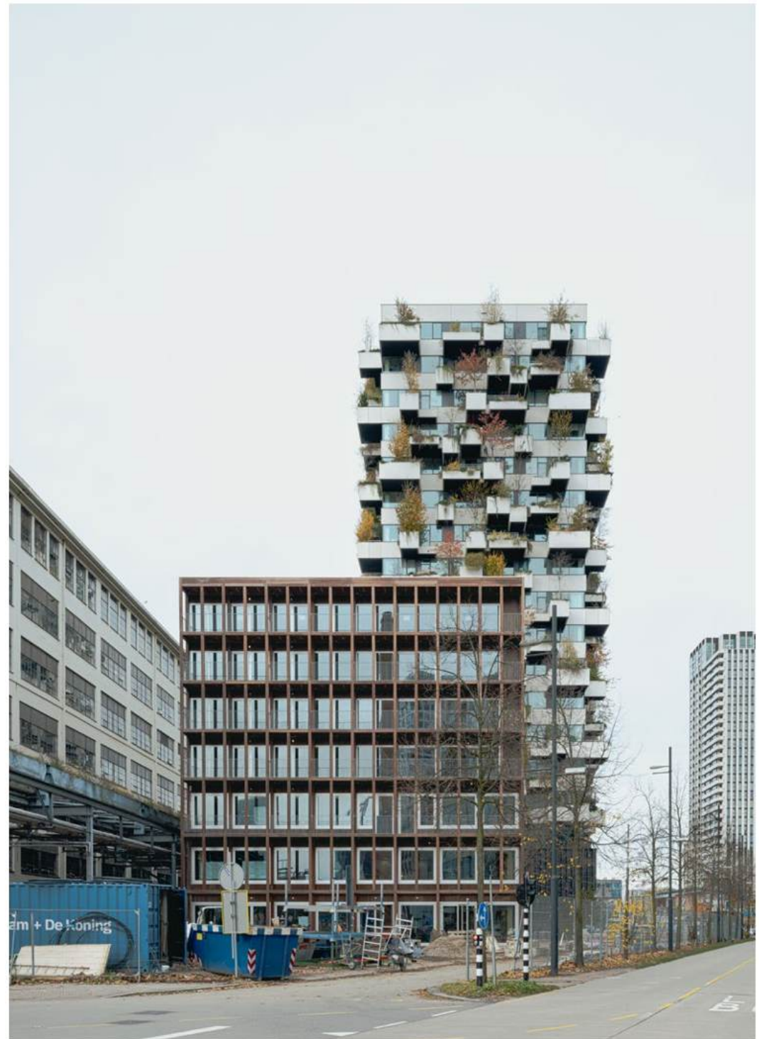
Oostaanzicht van Matchbox met de omliggende bebouwing in aanbouw en de gevel met de galerijen
