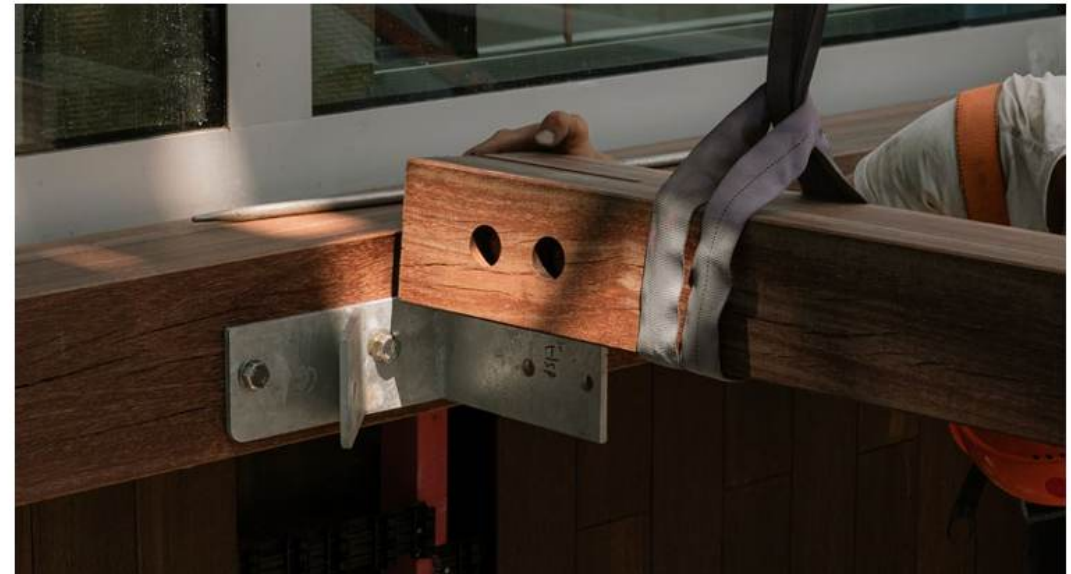
Bouwproces van de gevel, waarin de standaardisatie en de nauwkeurigheid van de houtmodules zichtbaar zijn. Detail 3
