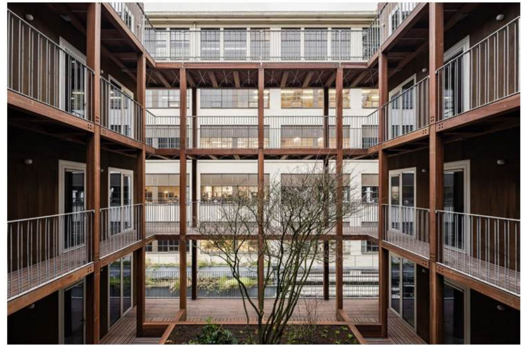
Aanzicht van de patio met de gemeenschappelijke ruimte voor de bewoners, waarin ook de relatie met de Apparatenfabriek op de achtergrond zichtbaar is
