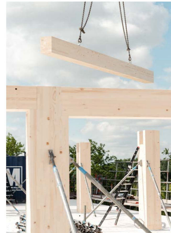
De houten constructie goed zichtbaar tijdens de bouw.
