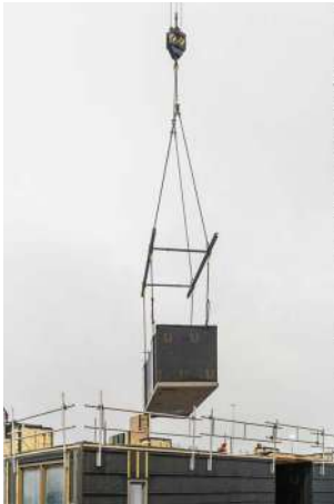
modules worden ingehesen
